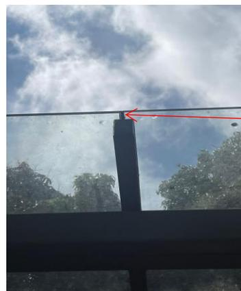
Selante estrutural com alta resistência à raios UV e UVB e com alto módulo de elasticidade
