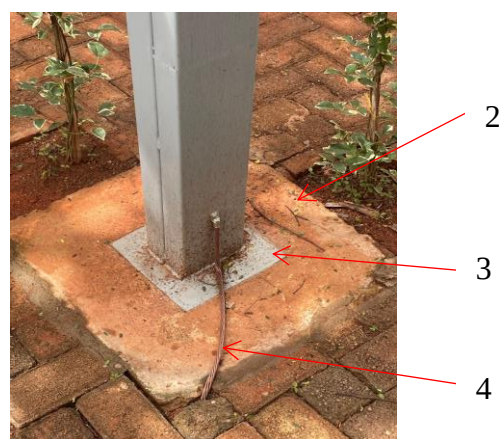
Figura 3 – Foto da composição do bloco de coroamento pilar e cabo de aterramento.
