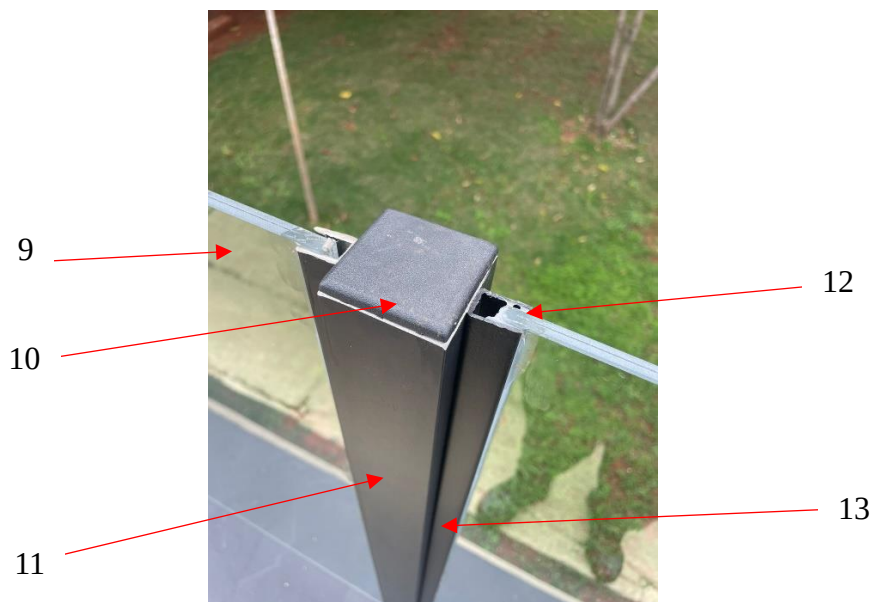
Figura 16 – Foto do guarda-corpo existente na Praça Duque de Caxias
