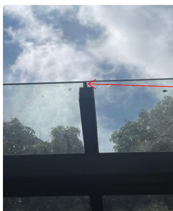
Figura 9 – Selante estrutural para unir 2 vidros da pérgola
