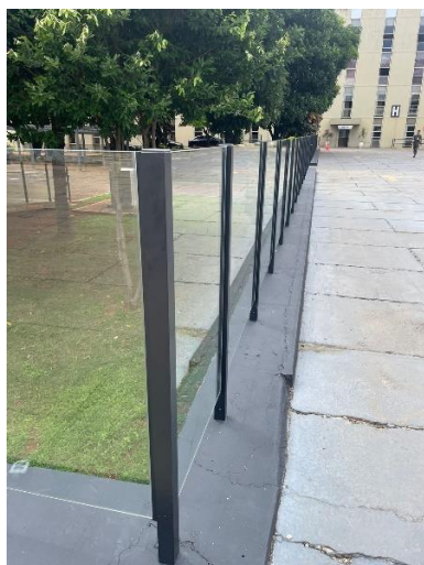
Figura 17 – Guarda-corpo da Praça Duque de Caxias
